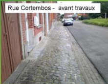
Rue Cortembos - avant travaux
