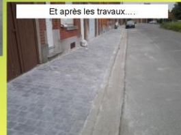
Et après les travaux....
